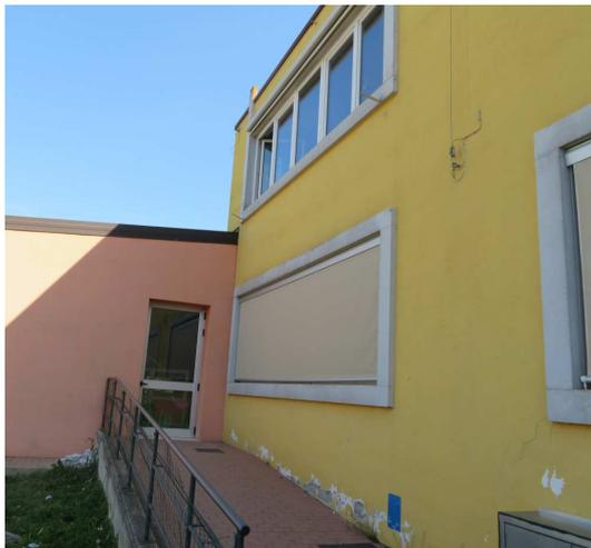
Figura 11 Fessurazione dei contorni finestre in c.a., umidità di risalita e muffa.
