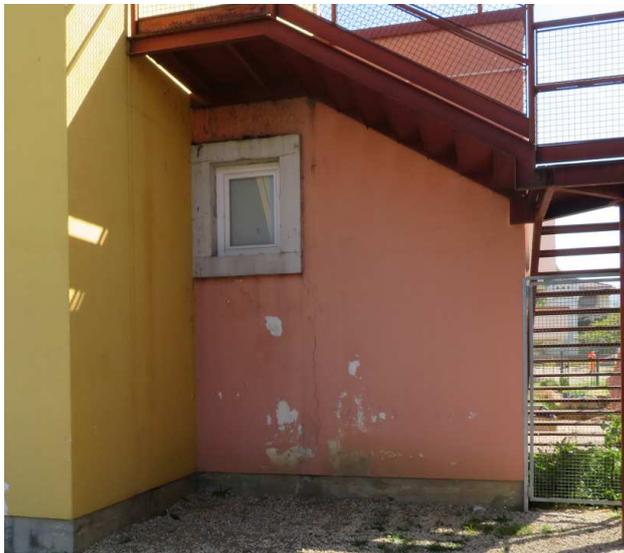
Figura 12 Fessurazione dei contorni finestre in c.a., umidità di risalita e muffa.
