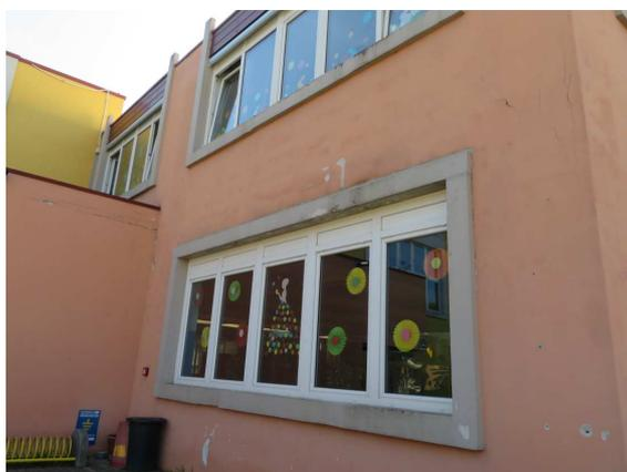
Figura 10 Fessurazione dei contorni finestre in c.a., umidità di risalita e muffa.
