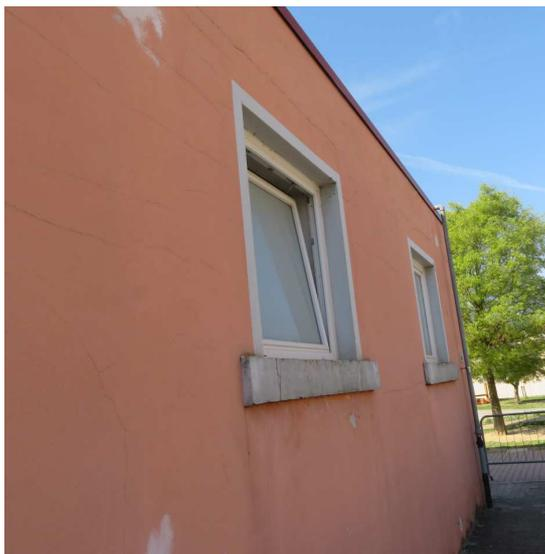
Figura 8 Fessurazione dei contorni finestre in c.a., umidità di risalita e muffa.
